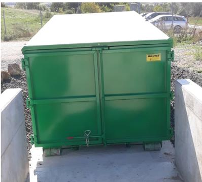
Seit geraumer Zeit verfügt auch unsere Gemeinde über eine solche wasserdichte aus Beton und Stahl gebaute „Bucht“ in der ein Container zum Beladen abgestellt werden kann. Doch leider wurde bei der Bauplanung bzw. Umsetzung die Breite des neuen Containers unterschätzt. Rechts und links fehlen jeweils ca. 20 cm, um den Container auf seinen vorgesehenen Platz zu rangieren. **Oder deutlicher gesagt: Das Ding passt da nicht rein.** Wir sind gespannt, wie diese Panne behoben werden soll.
